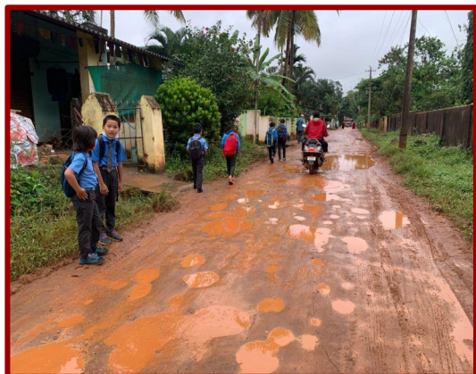
Foto 23: Straße in der Siedlung Doeguling vor der Instandsetzung
