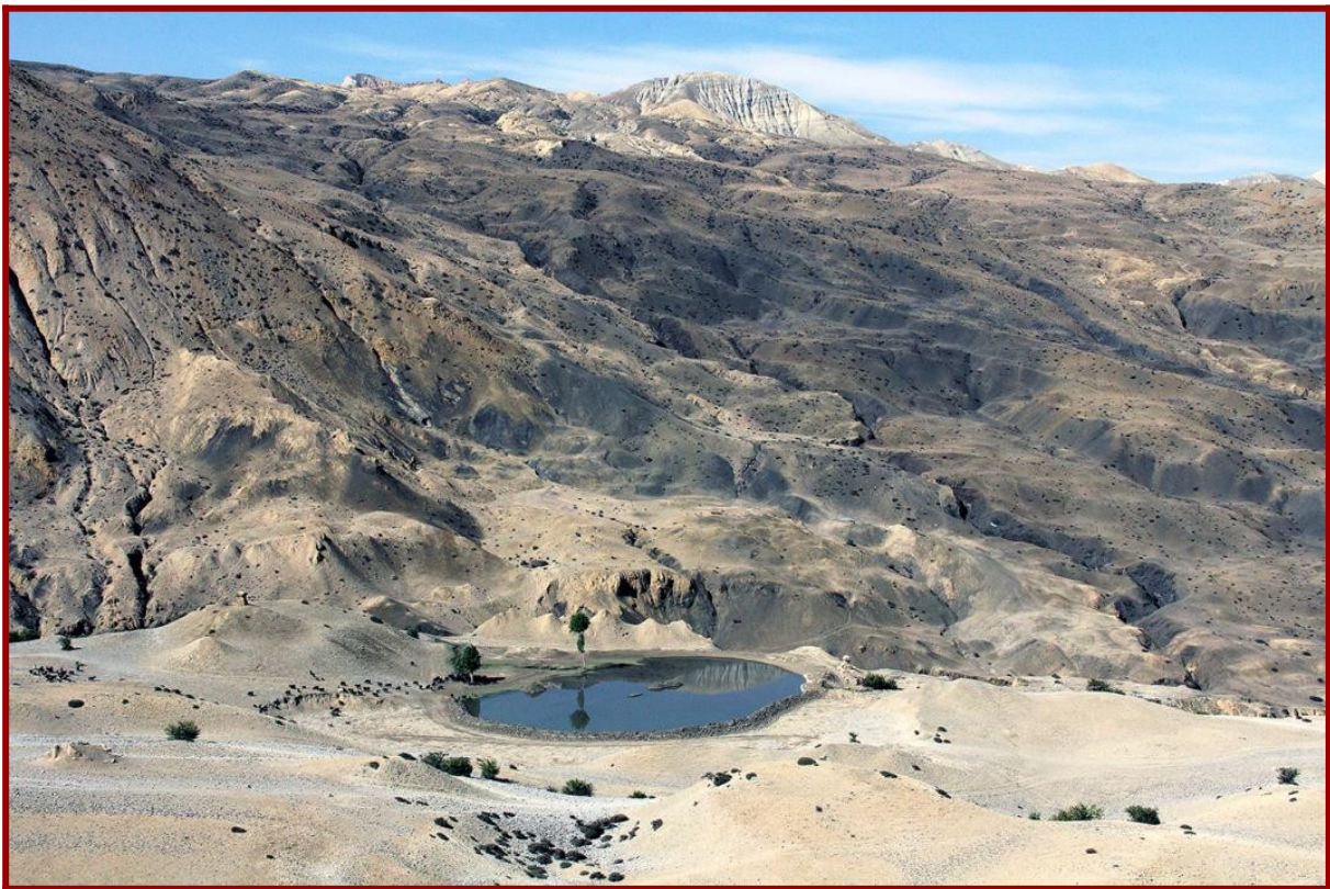
Foto 30: der undichte Wasserspeicher in Yara
