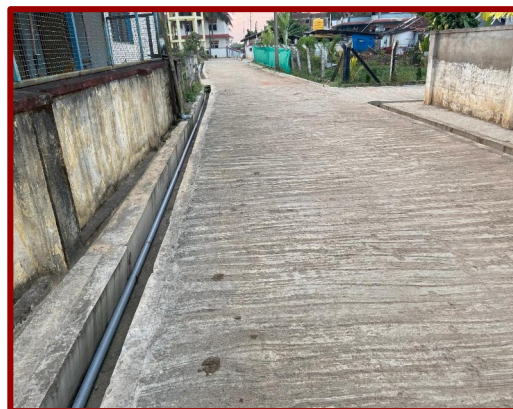
Foto 24: eine Straße nach Beendigung der Sanierungsarbeiten
